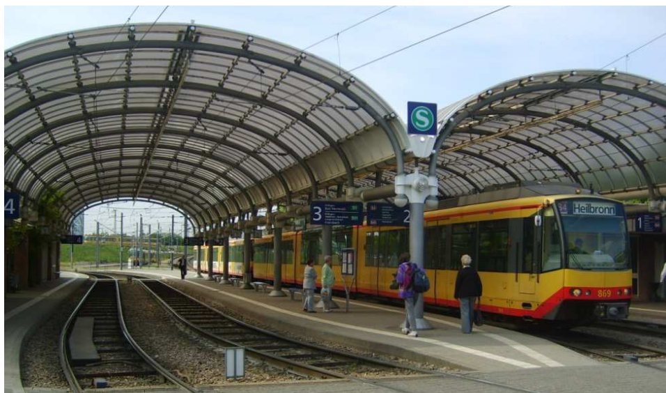
Rys. 9.6. Przykład tramwaju dwusystemowego w miejscu połączenia z linią kolejową (Karlsruhe, Niemcy). Źródło: materiały własne TRAKO.
