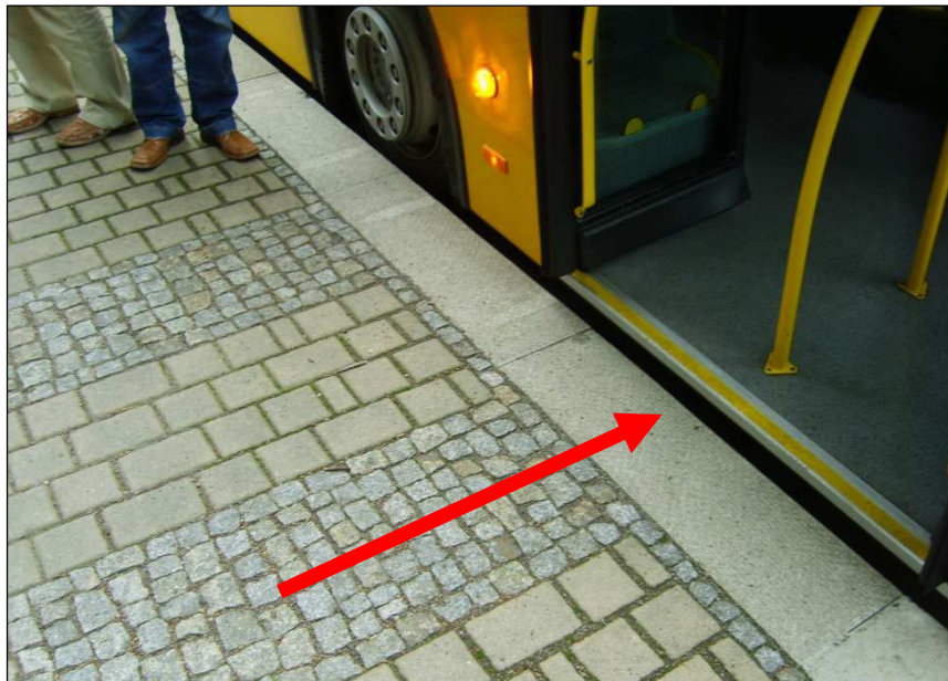
Rys. 7.7. Strefa wejściowa – inny rodzaj nawierzchni naprzeciwko pierwszych drzwi autobusu. Źródło: materiały własne TRAKO.
