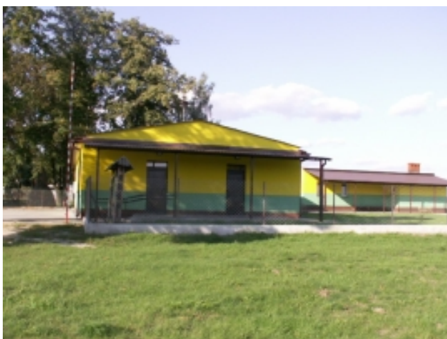
Odnowiony budynek świetlicy wiejskiej.
