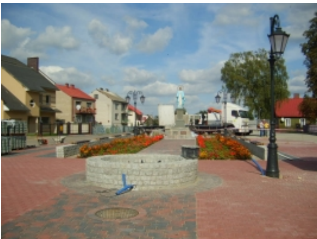
Odnowione centrum Troszyna
