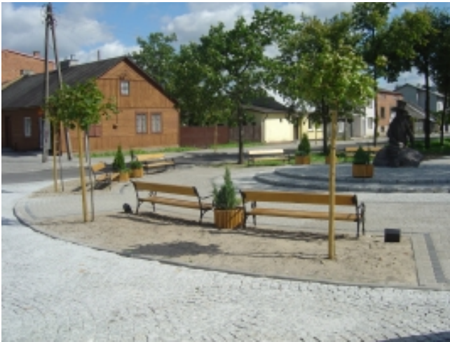
Renowacja głównego placu w Jedlińsku
