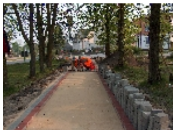
Prace budowlane w parku.
