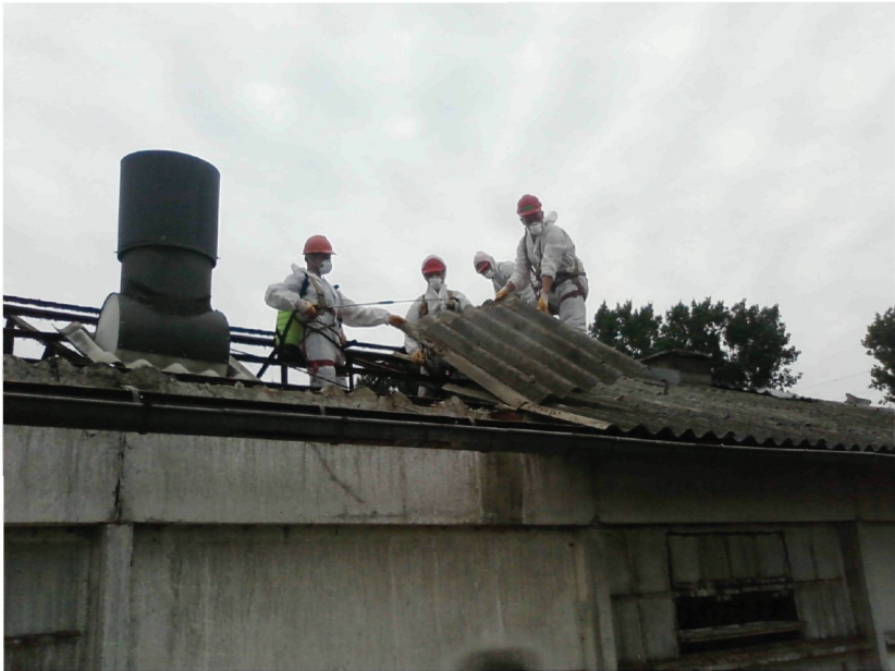
Bezpieczne usuwanie płyt azbestowych przeprowadzane przez ekipy specjalistycznych przedsiębiorstw
