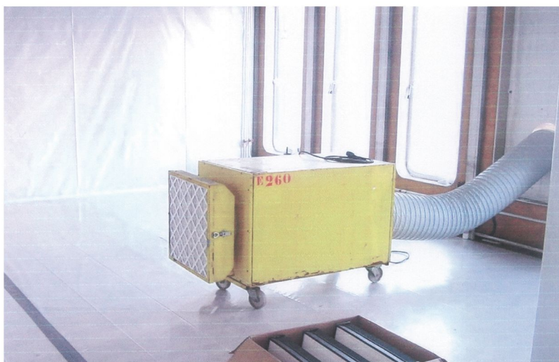
Wentylator podciśnieniowy do prac przy usuwaniu azbestu w pomieszczeniach zamkniętych
