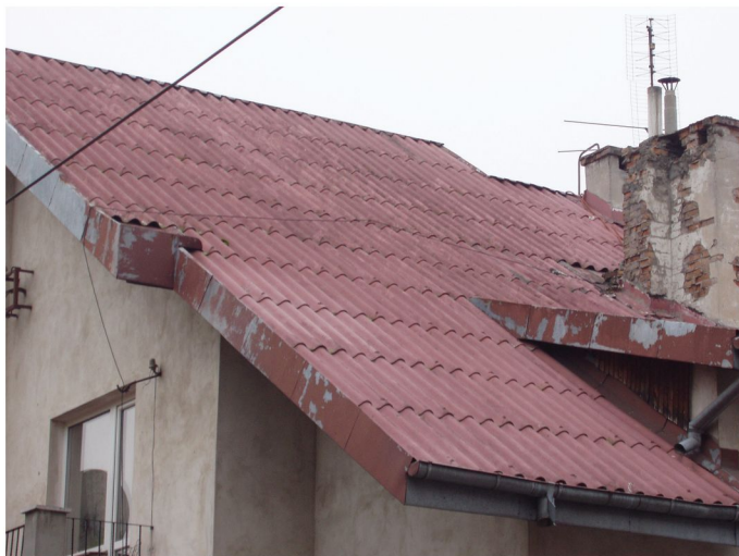
Płyty dachowe zabezpieczone preparatem penetrującym, który na trwałe wiąże włókna azbestowe
