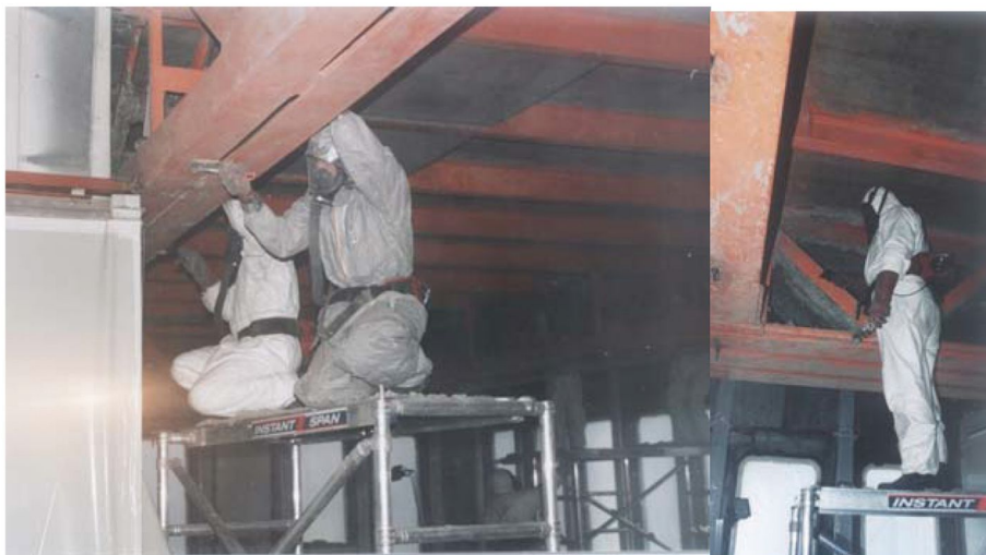
Prawidłowe zabezpieczenie osobiste przy skuwaniu otuliny cementowo-azbestowej
