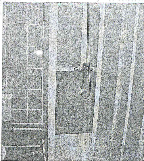
Łazienka (kabina prysznicowa)
