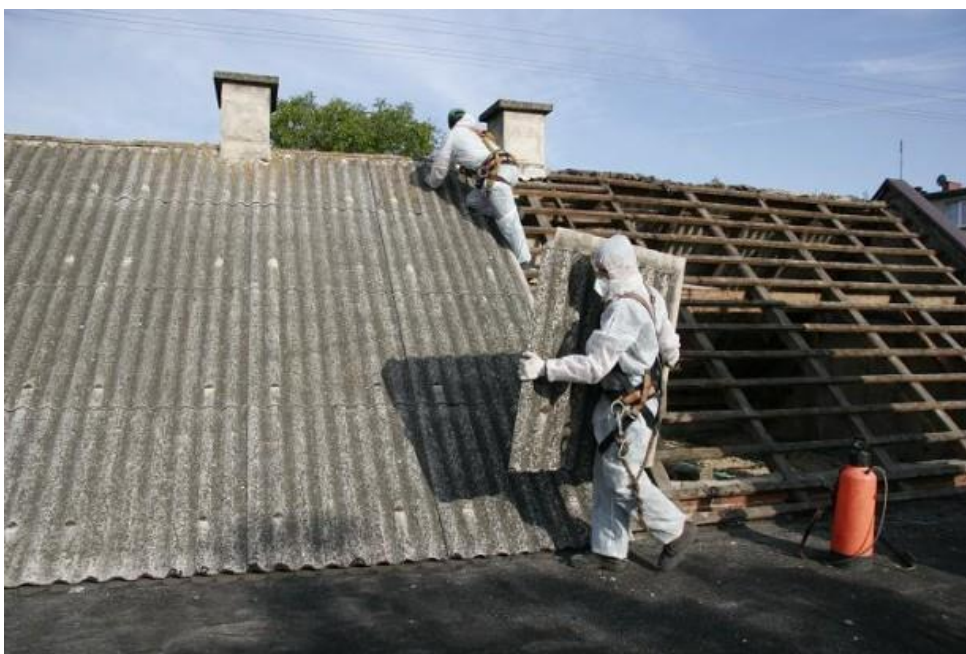
Rysunek 11 Demontaż wyrobów zawierających azbest 28
